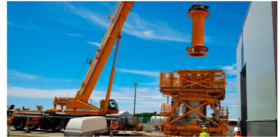
Essai en charge du chariot de manutention du combustible utilisé sur l'EPR OL3
