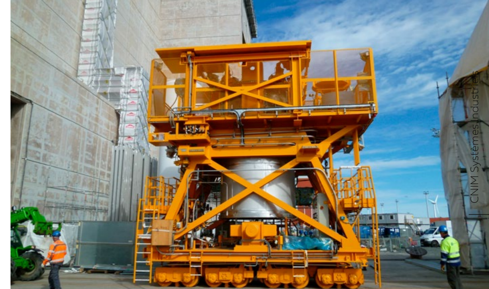
Chariot de chargement et déchargement du combustible usé de l'EPR OL3 en Finlande
